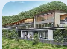
栃木県立 みかも自然の家
