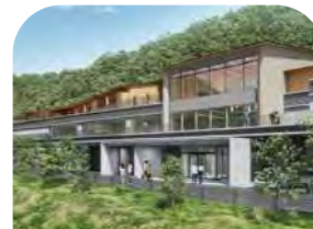
栃木県立 みかも自然の家
