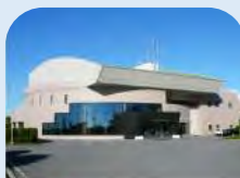
SFH 白浜フローラルホール
