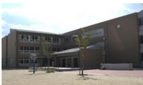
対象施設外観（四日市市立港中学校）
