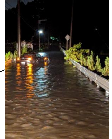
佐倉市 床上浸水39棟、床下浸水127棟
