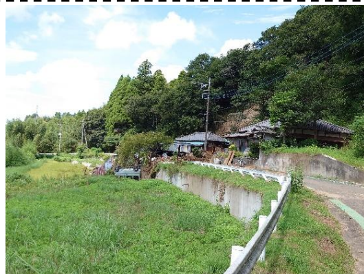
土砂災害(千葉県千葉市緑区越智町)
