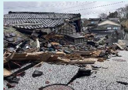
【旧角海家住宅(重要文化財) 倒壊の様子】
