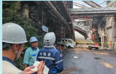
【煙突倒壊後の八代工場】
