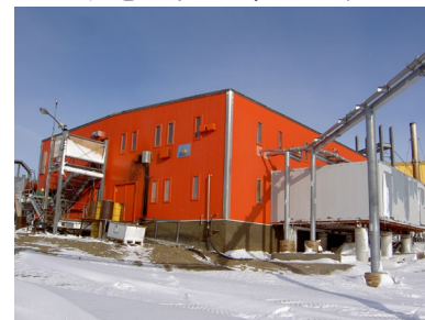
発電棟 1983年（築43年）
