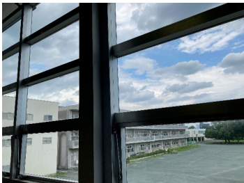
既設窓ガラスの内側に遮熱フィルムを施工
