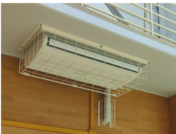
キャットウォーク床に固定して室内機を設置し、専用架台を設けることなく施工
