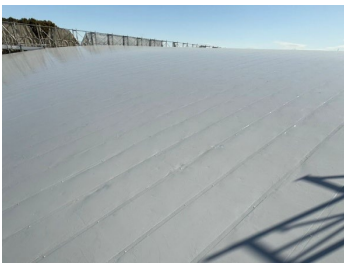
既設屋根面に遮熱塗装を施工
