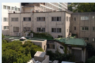
老朽化と機能劣化が著しい校舎
