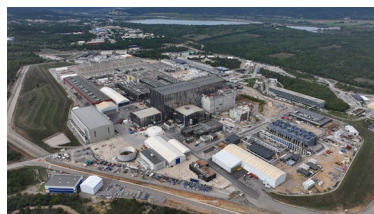
ITERサイトの建設状況
