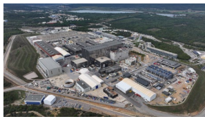
ITERサイトの建設状況
