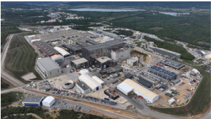
ITERサイトの建設状況
