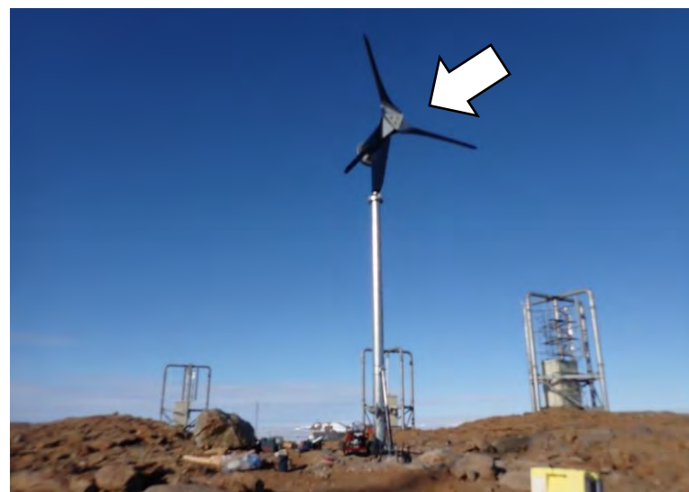
試験運用中の、第64次で新たに設置した風力発電装置
