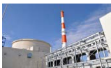
高速実験炉「常陽」
