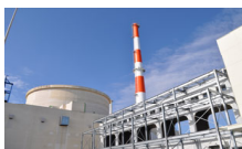
高速実験炉「常陽」
