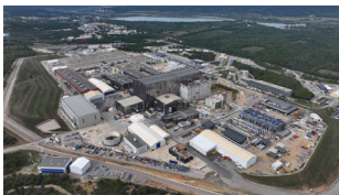
ITERサイトの建設状況
