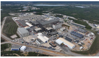
ITERサイトの建設状況
