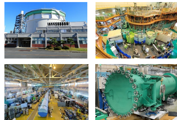
JRR-3(原子炉建家外観、炉室、ビームホール、SANS)
