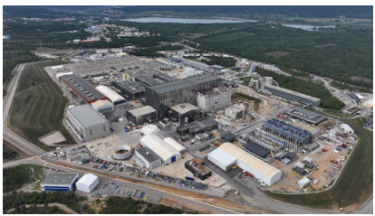
ITERサイトの建設状況
