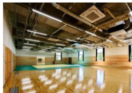
アリーナの空調設置
