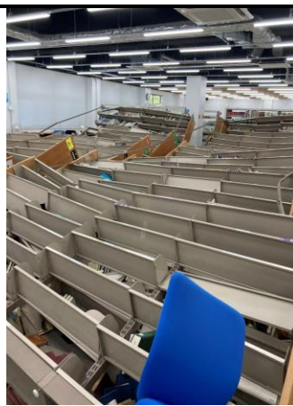
図書館内の書棚の転倒 熊本高専(八代キャンパス)
