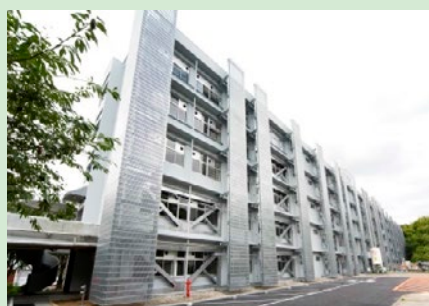
耐震補強と外壁の改修
