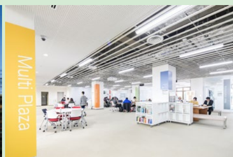
老朽化した図書館の改修
