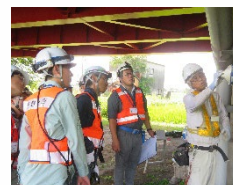
橋梁の点検手法の実習の 風景
