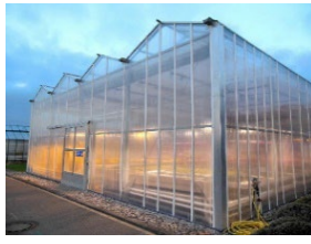
(スマート農業対応温室)
