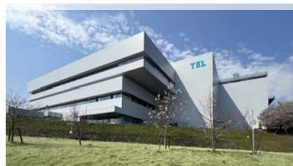
東京エレクトロン宮城 第3開発棟
