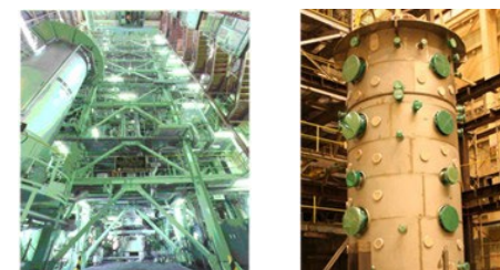
熱水流動挙動試験設備
