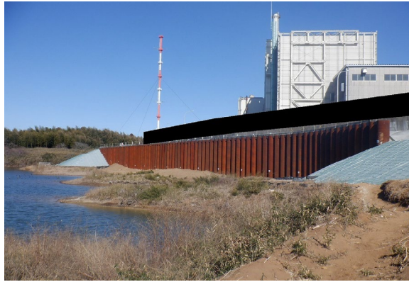
⑤森林火災対策： 建物周囲に防火帯を設置
