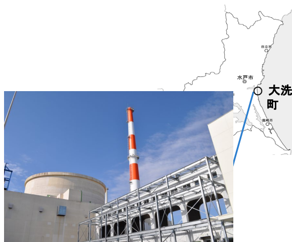
高速実験炉「常陽」
