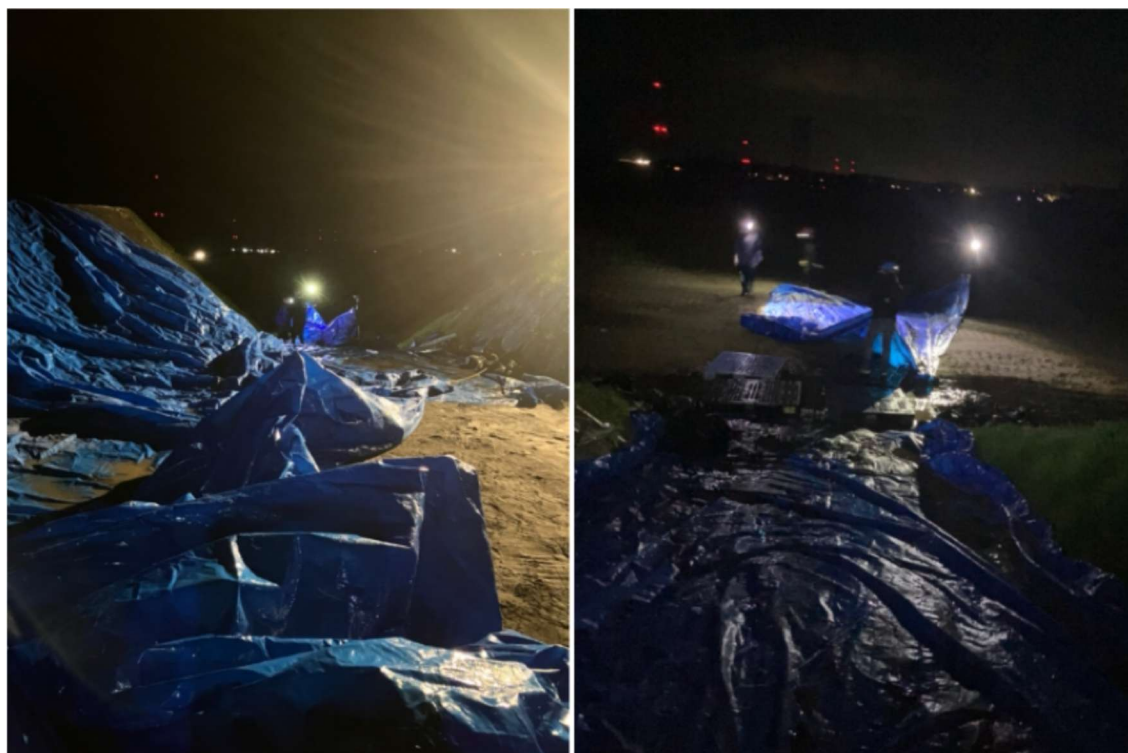
図 2.3-6 実習会前日の準備風景(ブルーシートを剥がして翌日の準備を行った)
