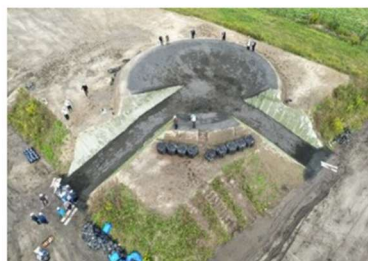
「月火星箱庭教育プログラムによる宇宙情報系人材の育成基盤構築」の活動の一環として福島ロボットテストフィールドに造成したローバ等評価用クレータ（直径22m）の全景（画像は(株)ふたばさんによる撮影）
