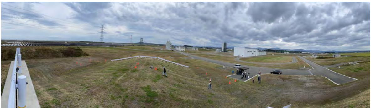
図 2.2-17 実習会風景（緩傾斜エリア全景）
