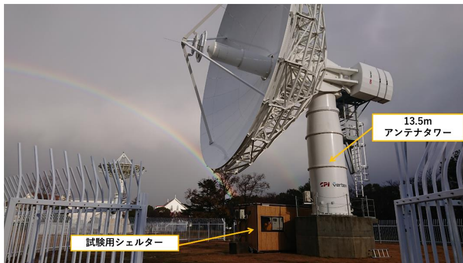
図 3-2-2 13.5m アンテナタワーおよび試験用シェルター
