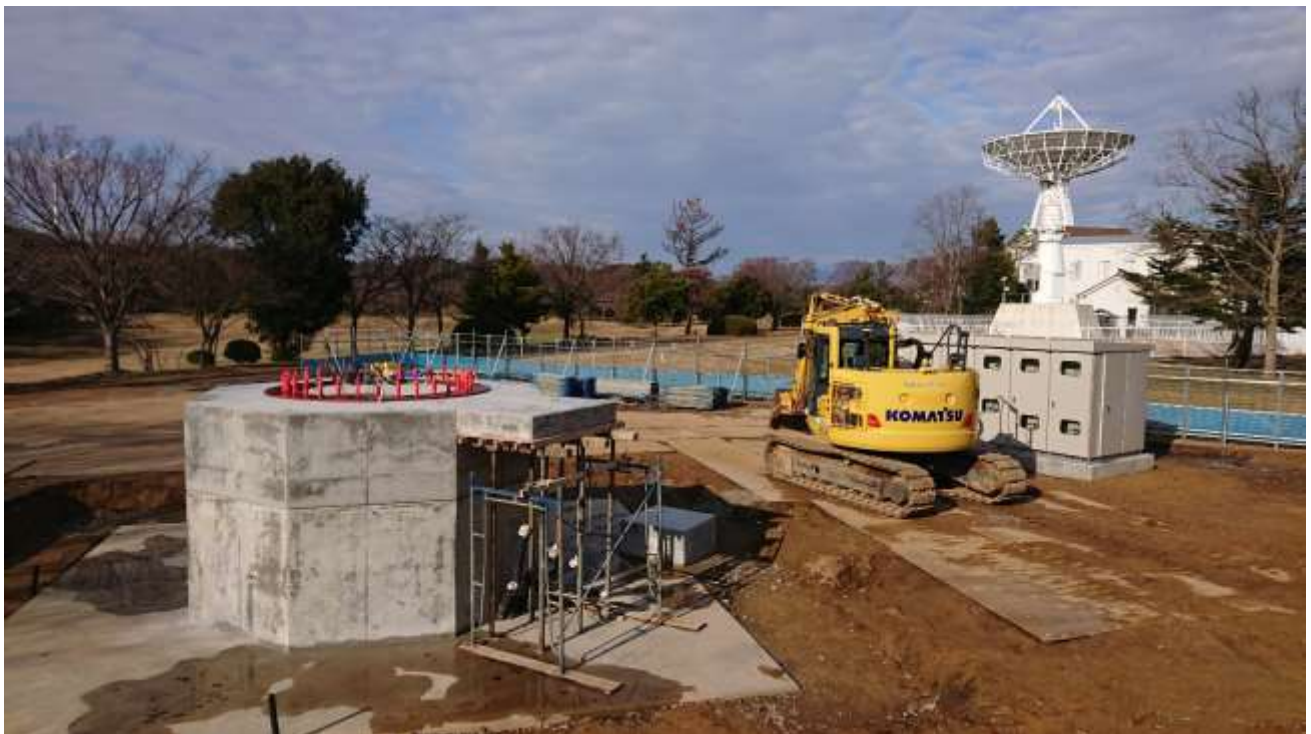
図3-2-1. 2023年2月23日時点での口径13.5mアンテナの建設状況。アンテナの基礎工事までが完了している。
