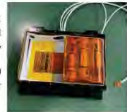
図 3 バッテリーボックス作成の様子
