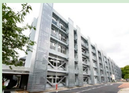
耐震補強と外壁の改修
