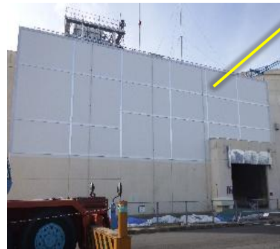
①竜巻対策： アラミド繊維シートを用いた 建物外壁補強
