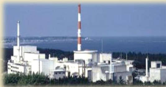
高速実験炉「常陽」
