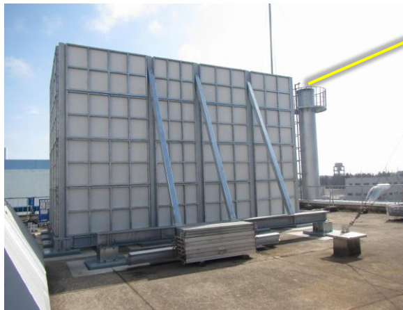
①②耐震・竜巻対策： 屋上に設置されているディーゼル発 電機の冷却水の冷却塔の耐震補 強と竜巻防風壁の設置
