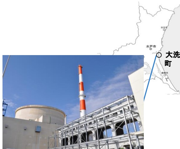
高速実験炉「常陽」
