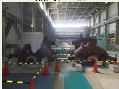
蒸気タービン解体物（搬出前）
