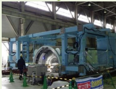
大型バンドソーによる固定子切断作業
