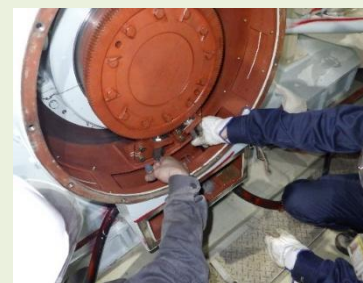
発電機電磁ピックアップ部解体
