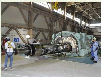
ローター引き抜き作業
