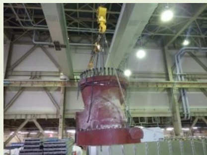
蒸気タービン解体物の搬出作業
