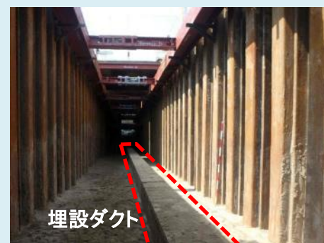
埋設ダクト内排水管(掘削後)
