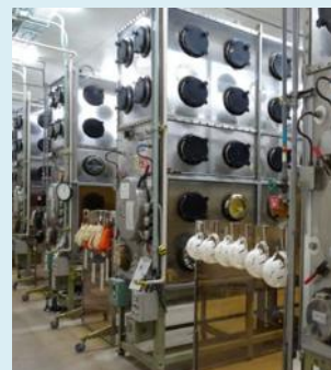
MOX燃料製造用GB(解体前)
