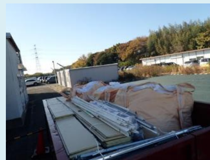
NR搬出(除湿ルーム)
