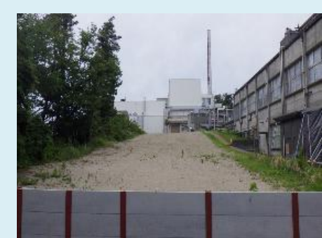
埋設ダクト内排水管(埋め戻し後)
