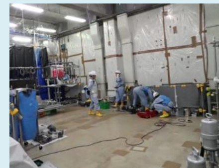
MOX燃料製造用GB(解体後)
