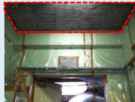
アスベスト(撤去後)
