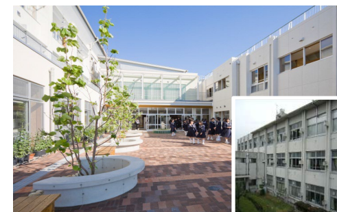
長寿命化改修により建て替え同等の教育環境を確保
