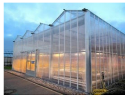
(スマート農業対応温室)
