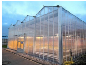
(スマート農業対応温室)
