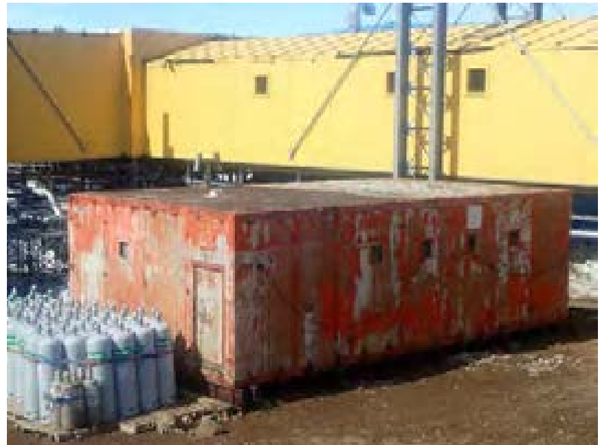
現在の旧主屋棟（2019年2月撮影）
