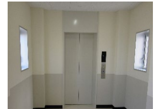
(校内エレベーター)
