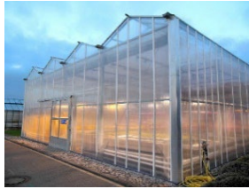
(スマート農業対応温室)
