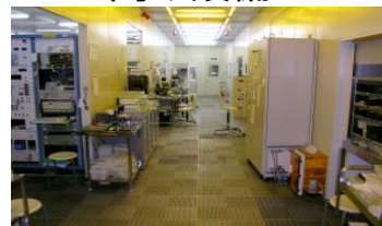
スーパー クリーンルーム
