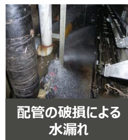
配管の腐食
