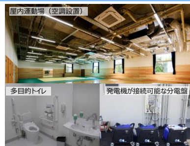
体育館の高台移転（津波対策）時に防災機能を強化 （和歌山工業高等専門学校「総合体育館」）
