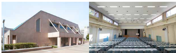
講堂棟 講堂棟 内部
