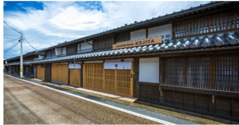
旧荻田家付属町家群を活用した公共施設等運営事業 (岡山県津山市)
