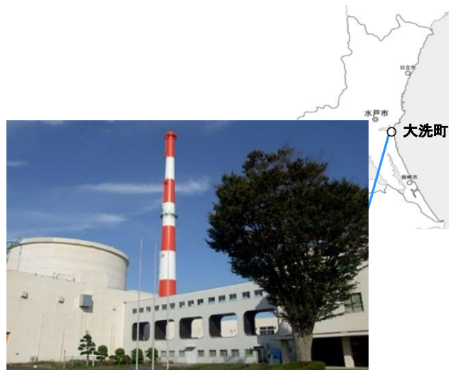
高速実験炉「常陽」
