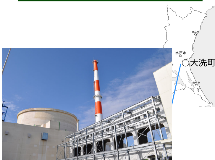
高速実験炉「常陽」
