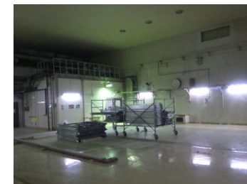
第1除湿ルーム（解体後）
