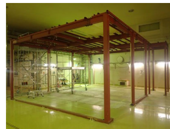
第1除湿ルーム（天井・壁撤去後）
