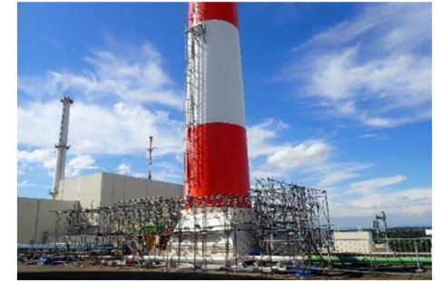
主排気塔の耐震補強
