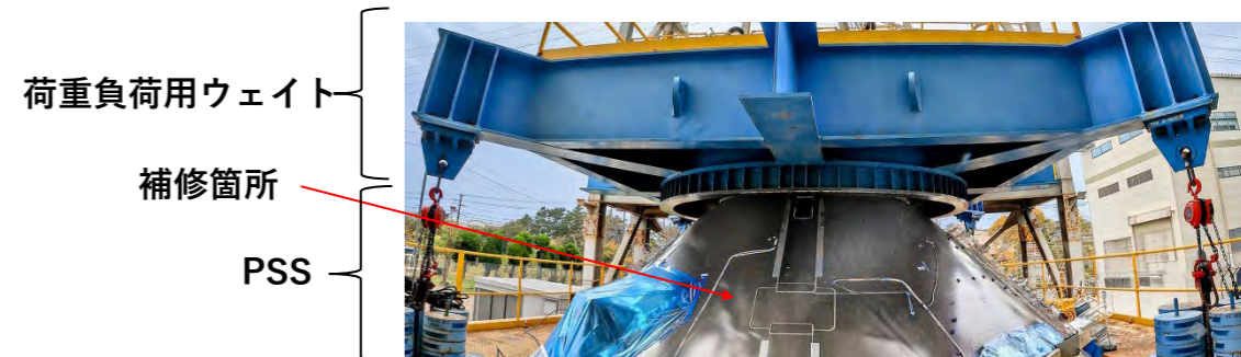
検証試験の様子
