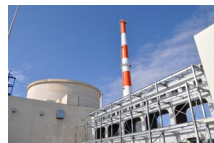
高速実験炉「常陽」
