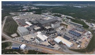
ITERサイトの建設状況
