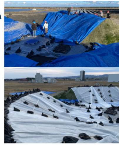
上：当初ブルーシートによる保護作業 下：メッシュシートに切り替え後のカバー状況
