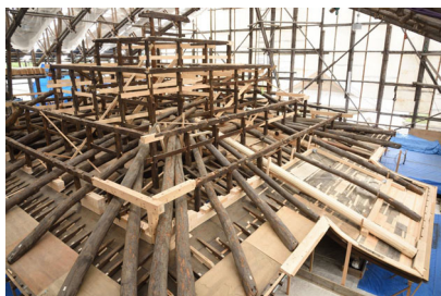
小屋組の修理状況
