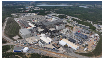
ITERサイトの建設状況
