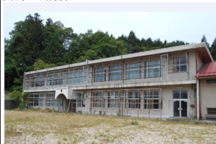
校舎等の外観写真
