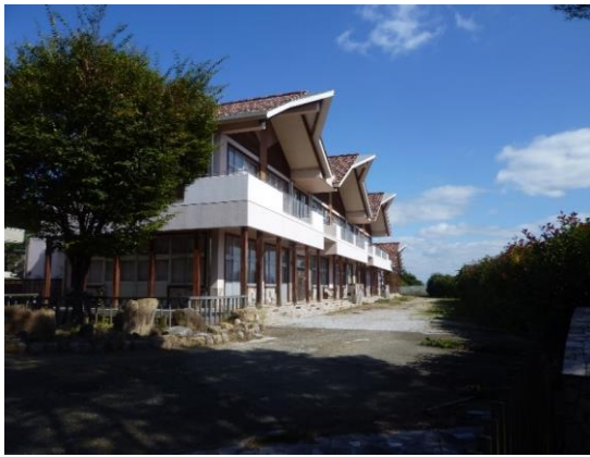
校舎等の外観写真
