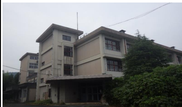
校舎等の外観写真
