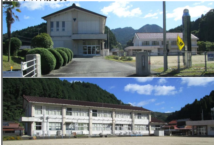
校舎等の外観写真
