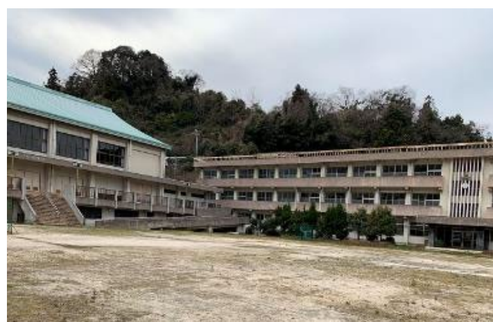
校舎等の外観写真
