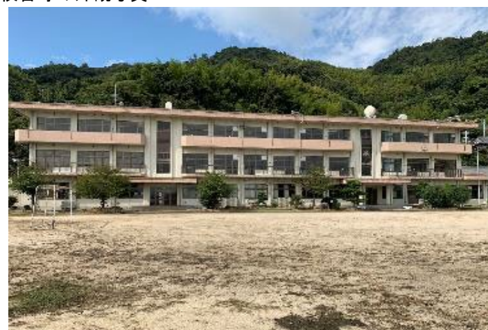
校舎等の外観写真
