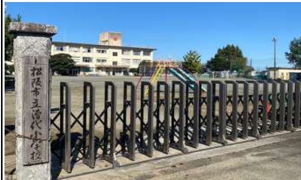
校舎等の外観写真
