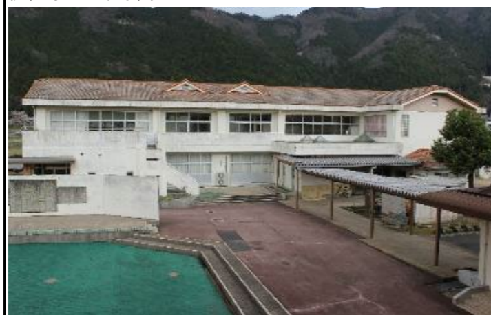
校舎等の外観写真
