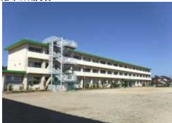
校舎等の外観写真
