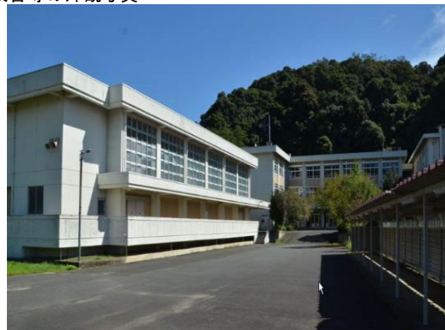
校舎等の外観写真
