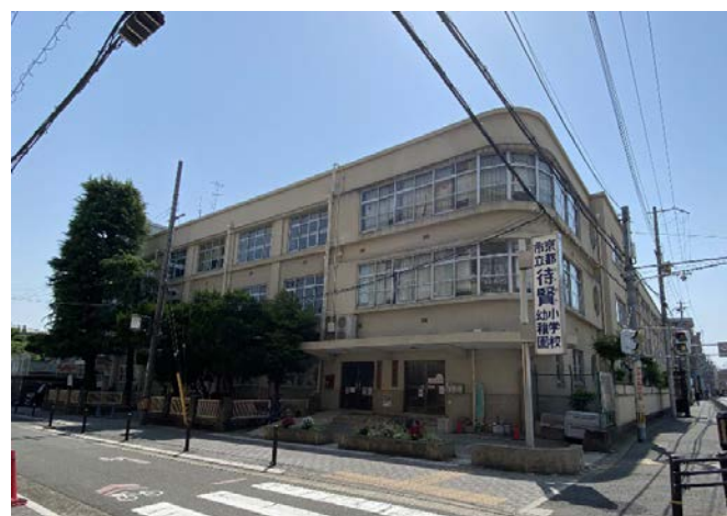
校舎等の外観写真
