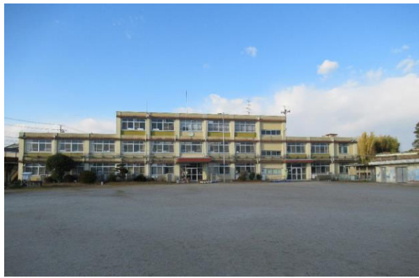
校舎等の外観写真
