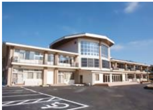
校舎等の外観写真
