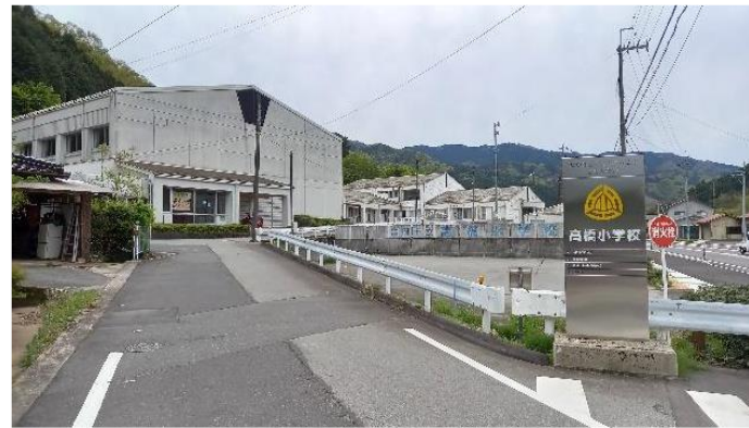
校舎等の外観写真
