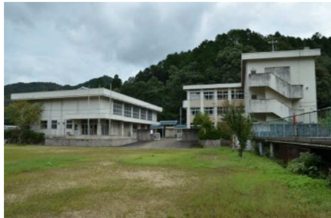
校舎等の外観写真
