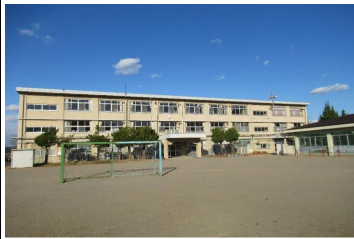
校舎等の外観写真
