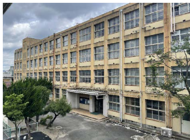
校舎等の外観写真
