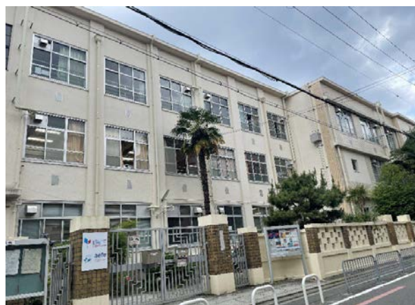
校舎等の外観写真
