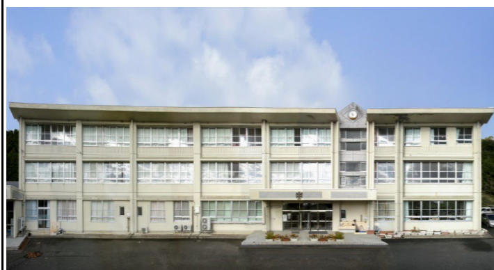
校舎等の外観写真
