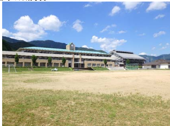
校舎等の外観写真
