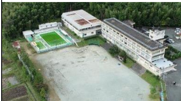
校舎等の外構写真
