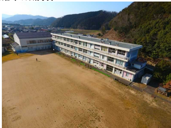
校舎等の外観写真
