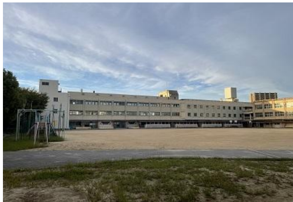
校舎等の外観写真
