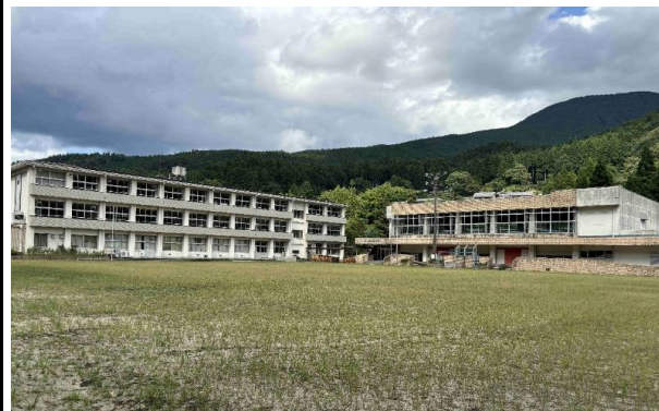
校舎等の外観写真
