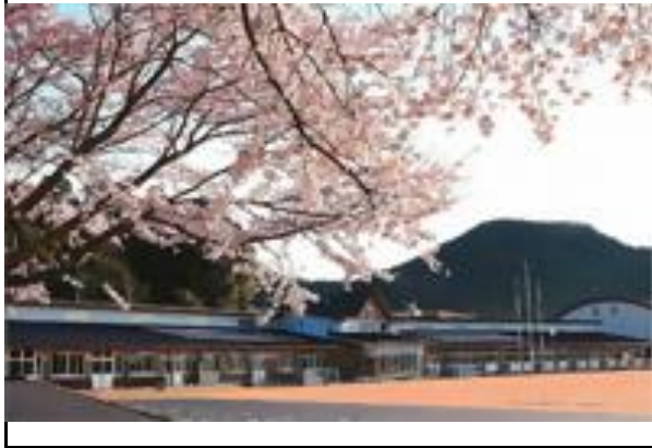
校舎等の外観写真
