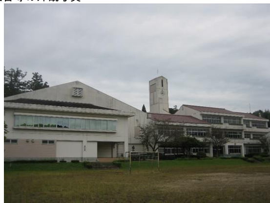
校舎等の外観写真
