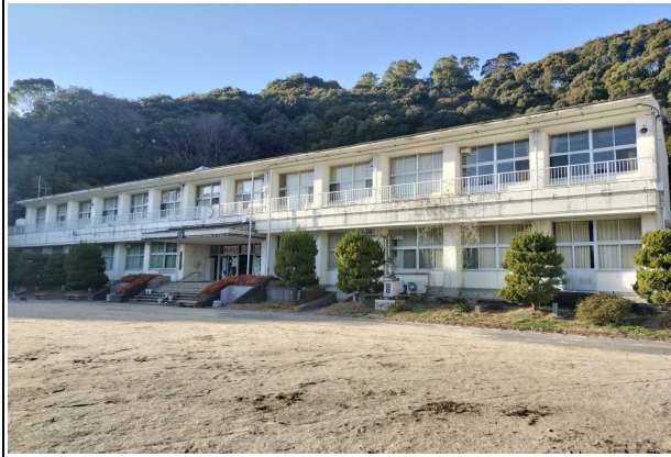
校舎等の外観写真
