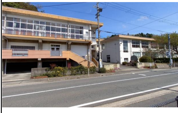
校舎等の外観写真
