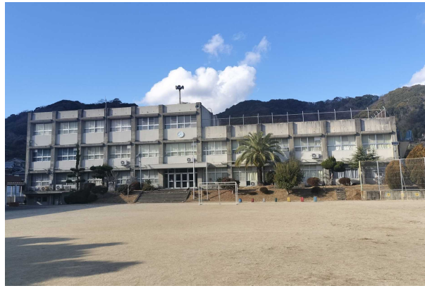
校舎等の外観写真
