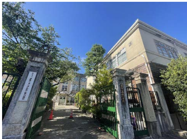
校舎等の外観写真
