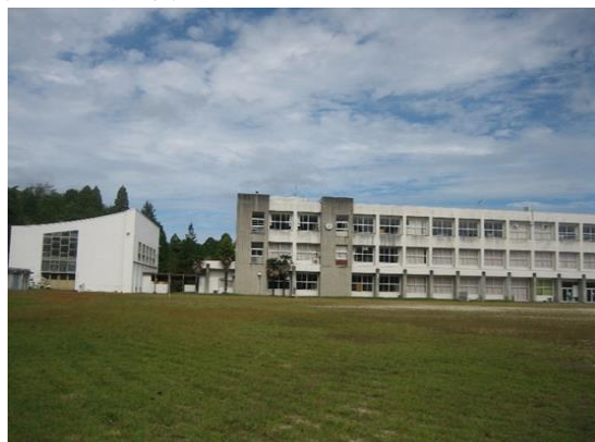
校舎等の外観写真
