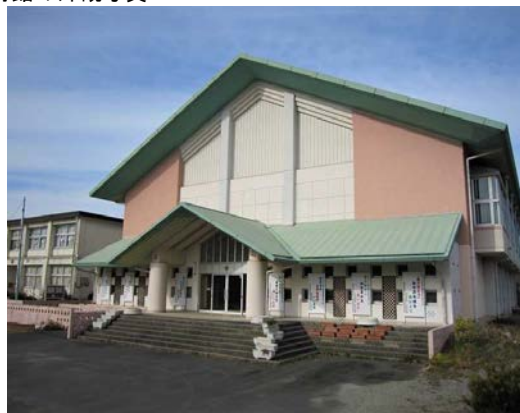
体育館の外観写真
