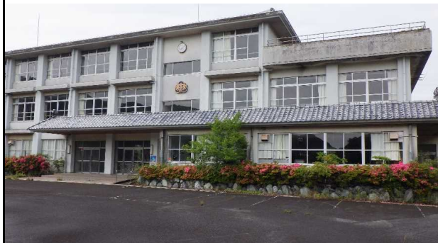
校舎等の外観写真
