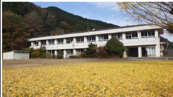
校舎等の外観写真
