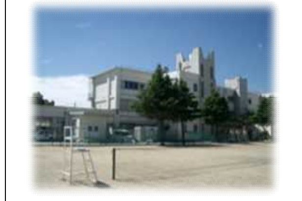
校舎等の外観写真
