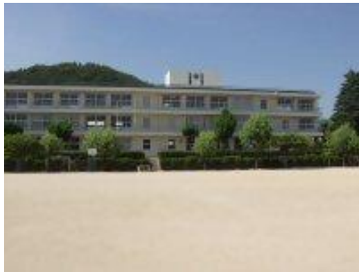
校舎等の外観写真
