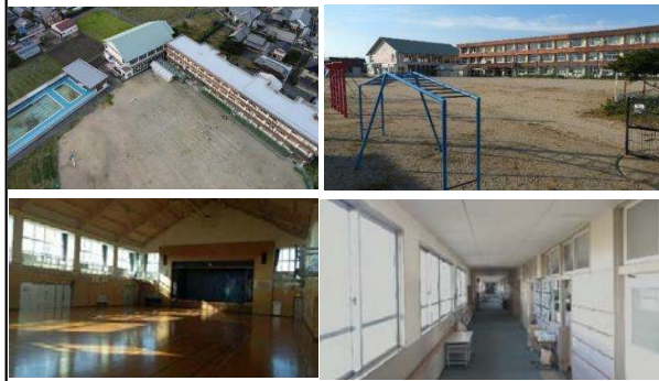
校舎等の外観写真
