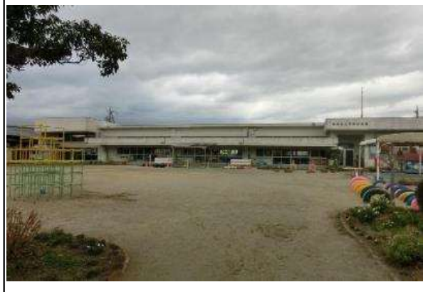
校舎等の外観写真
