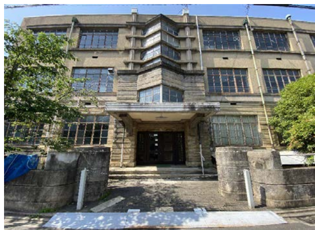
校舎等の外観写真
