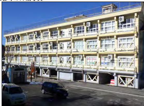
校舎等の外観写真
