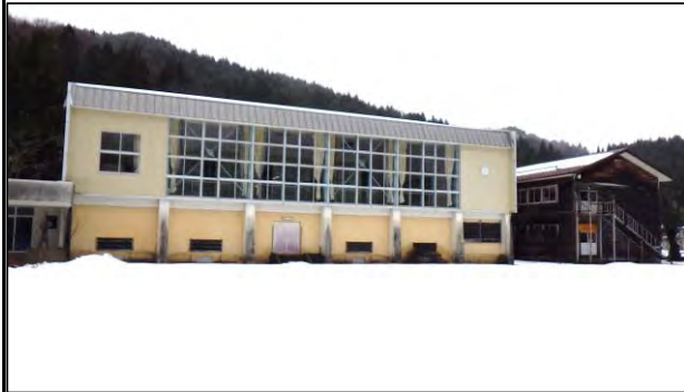
校舎等の外観写真
