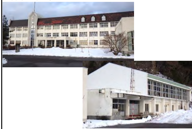
校舎等の外観写真
