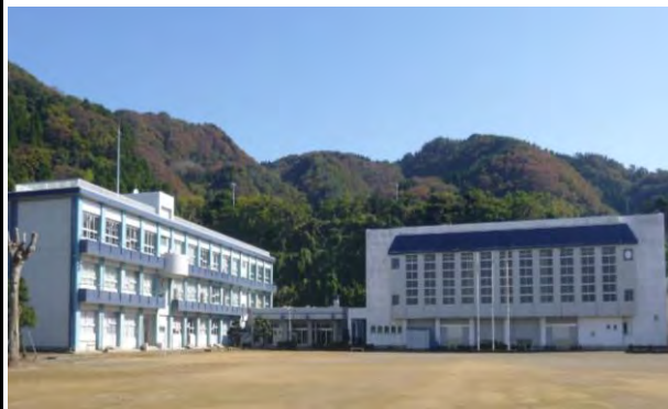
校舎等の外観写真
