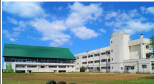
校舎等の外観写真
