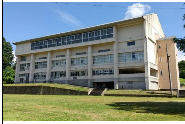
校舎等の外観写真
