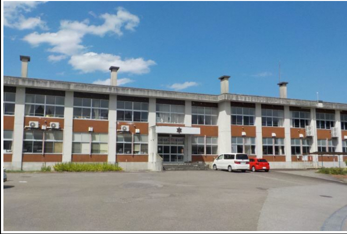
校舎等の外観写真
