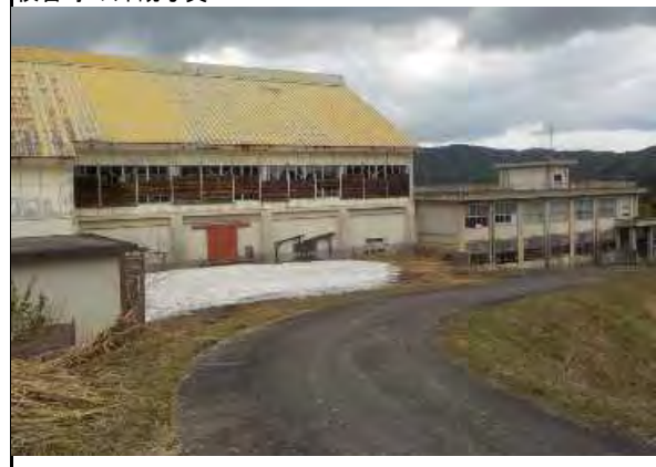
校舎等の外観写真
