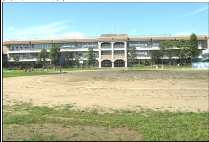
校舎等の外観写真
