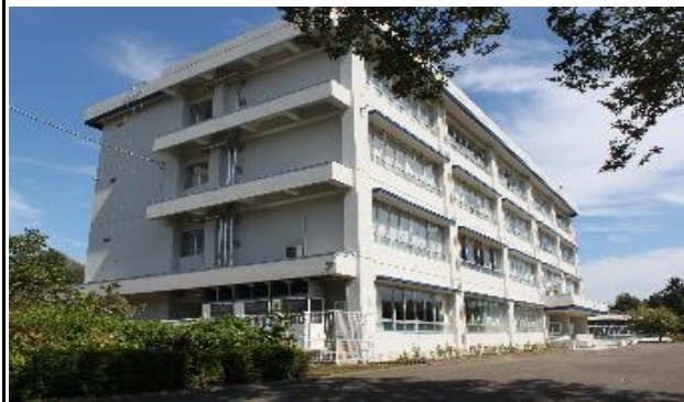
校舎等の外観写真
