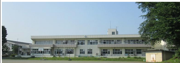
校舎等の外観写真
