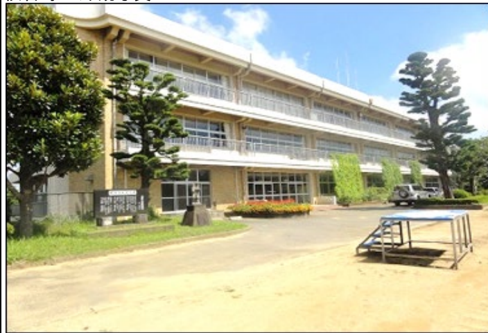
校舎等の外観写真
